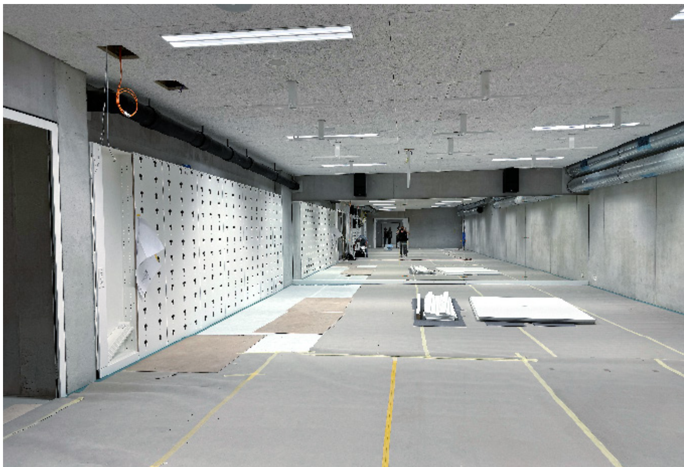
Abb. 1: Die multifunktionale Wand im Gymnastik- und Kraftraum ist eingebaut.
